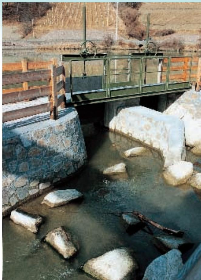
rale. Per consentire un'alimentazione continua ed una oscillazione minima del deflusso della scala è stato installato un sistema automatizzato di controllo delle paratoie all'interno dei canali d'adduzione dell'opera di presa della centrale. Ad ogni variazione di portata del fiume il sistema equilibra rapidamente le oscillazioni di livello nell'invaso così da ottenere
