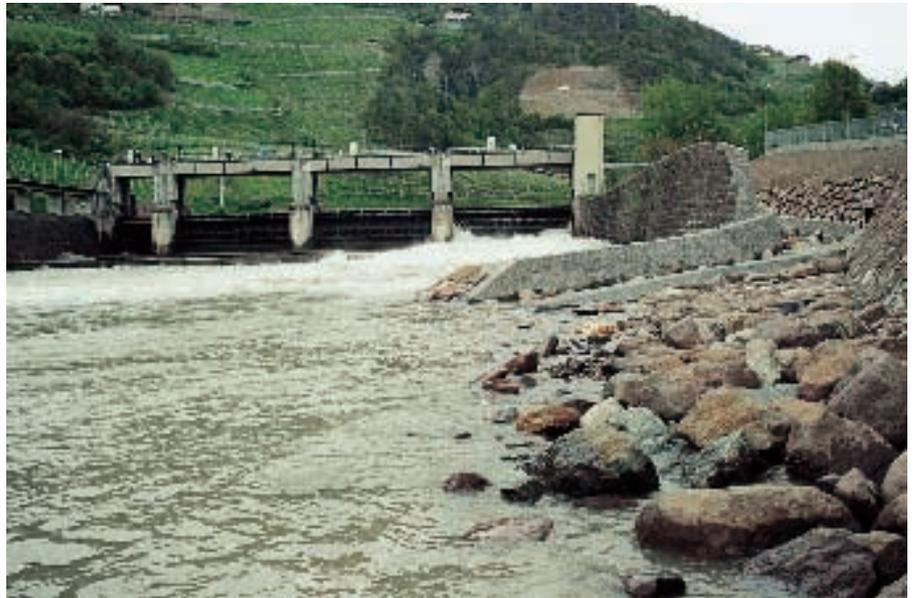
**Lo sbarramento idroelettrico sul Fiume Isarco e, sulla destra, l’imbocco del passaggio per i pesci recentemente ultimato (fase di morbida estiva)**
