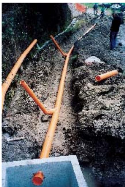
**La posa delle condutture per l'alimentazione idrica.**
