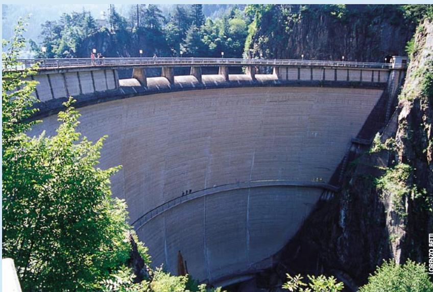
La diga è del tipo ad arco a doppia curvatura. Il materiale di costruzione è il calcestruzzo. Alta poco più di 60 metri, determina la quota di massima regolazione a 787 m s.l.m. mentre la minima regolazione è fissata a 761 m s.l.m.
