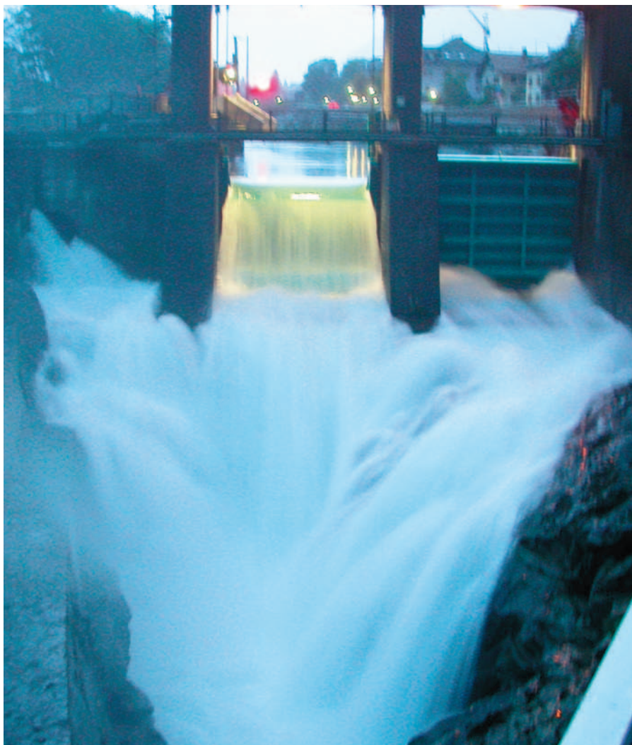
L'opera di presa dello sbarramento di Tel (Merano), sull'Adige, durante lo scarico.
