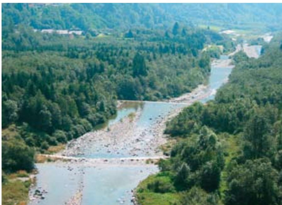
*La lunga serie di briglie nell'alveo del T. Vanoi, a monte (sopra) e a valle (sotto) del Ponte di Ronco.*
