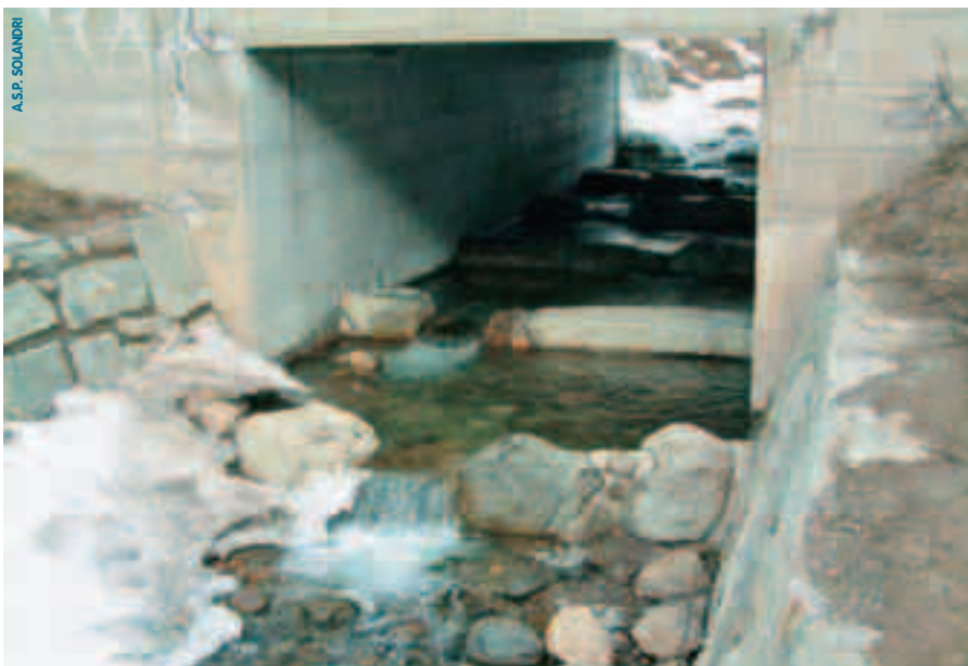
Il passaggio per pesci sul Rio Corda
