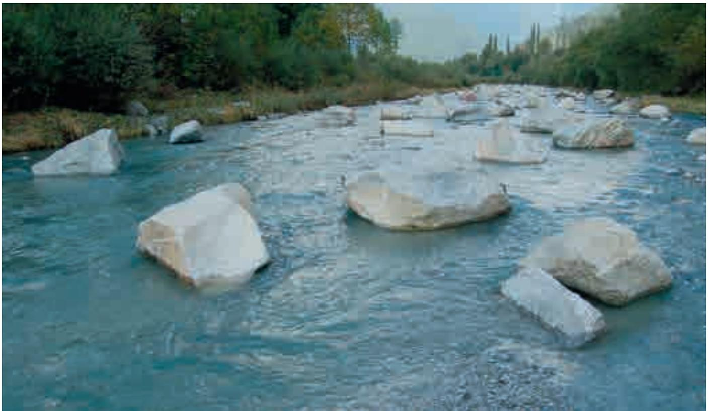
**3 ottobre 2012.** Foto 4. A valle della confluenza del Flanginech dopo la I morbida. Si vede un doppio flusso convergente e una piccola barra di deposito semisommersa (in basso a destra), prime tracce di una positiva differenziazione della morfologia fluviale, indotta da un articolato posizionamento di massi.
