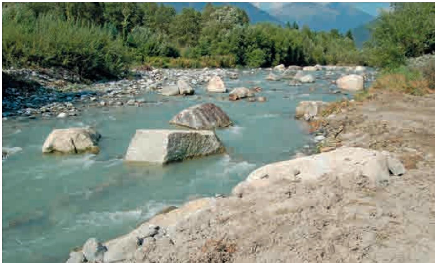
**6 settembre 2012.** Foto 2. In evidenza, in primo piano, un gruppo di 3 massi in configurazione a V rivolta verso monte: massi di grandi dimensioni hanno anche un effetto divergente sui flussi idrici; in questo caso prevale l'effetto di indirizzo della corrente in sponda destra, che è stata prudenzialmente protetta con altri massi.
