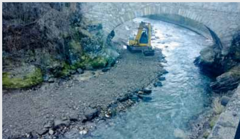
Il passaggio artificiale e quasi completato
