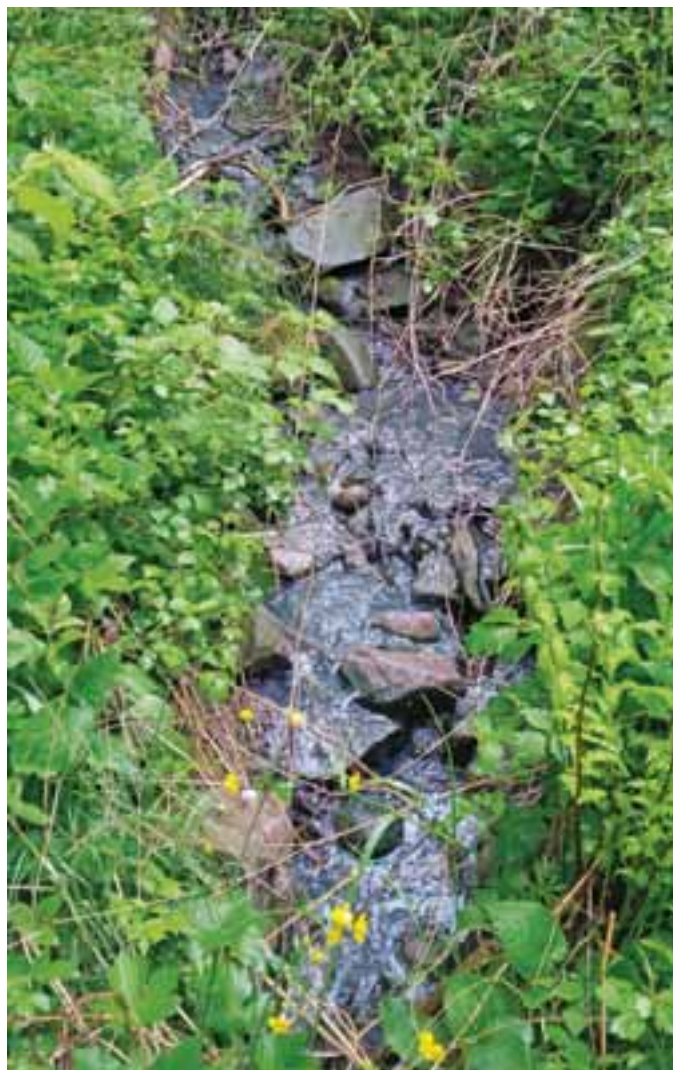
Scarico da fossa Imhoff non funzionante
