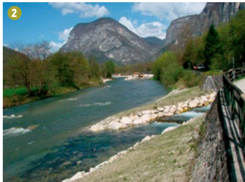
Confluenza della Roggia Resenzuola col Fiume Brenta, dopo l'intervento.
