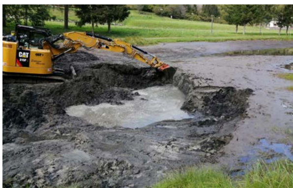
Lavori di rimozione limi laghetti San Leonardo.
